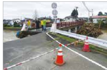
関東・東北豪雨の後（泉区）
