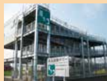
津波避難タワー（宮城野区中野）
