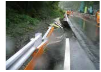
大雨で崩壊した道路
