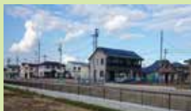
防災集団移転先の宅地造成（宮城野区）
