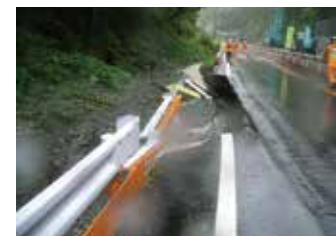
大雨で崩壊した道路
