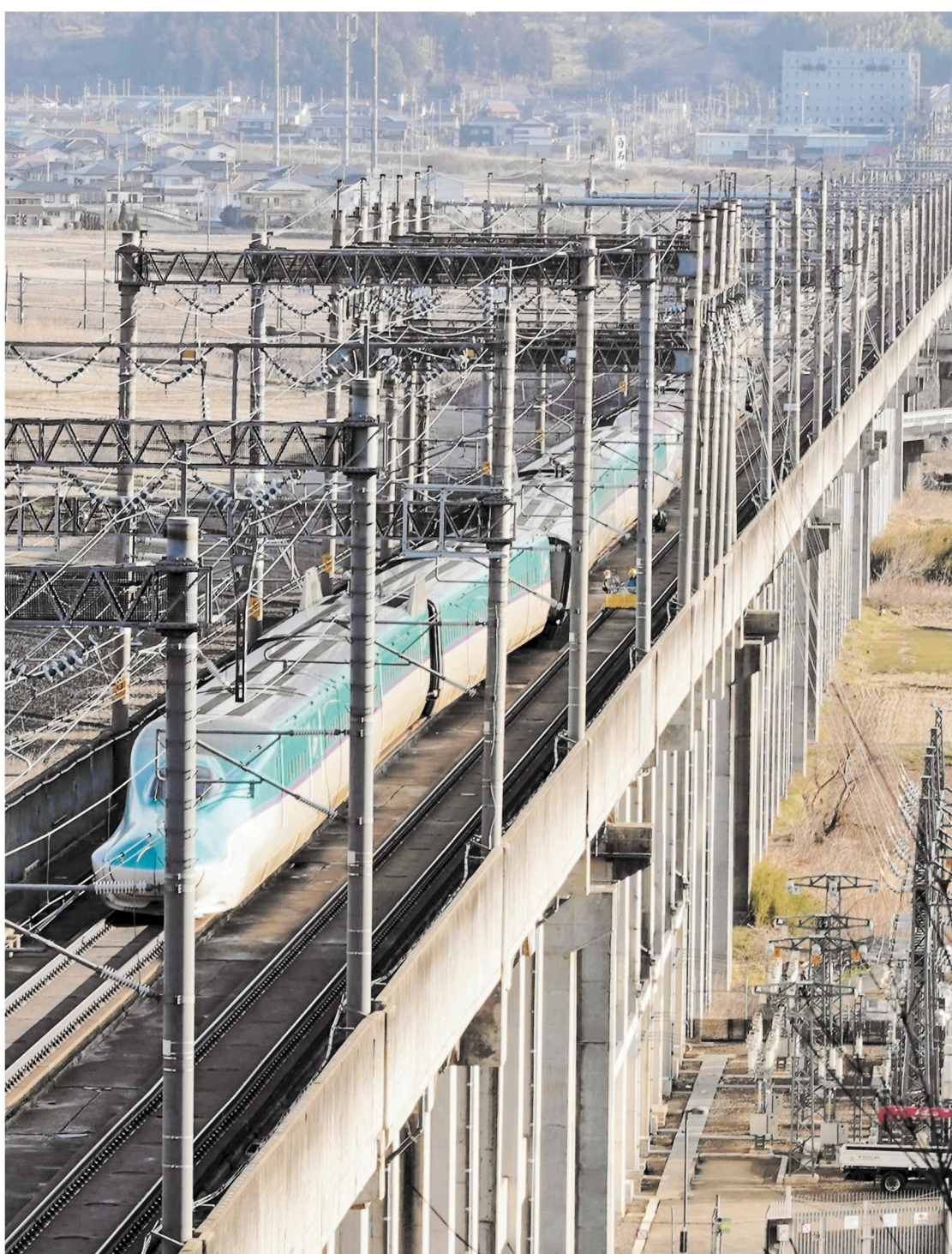
白石蔵王駅の約2キロ手前で脱線した東北新幹線やまびこ223号 =17日午前7時15分ごろ、白石市斎川
